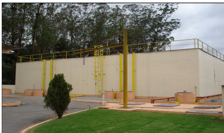
Figura 12: ETE Água Verde – Tratamento Secundário Reator Anaeróbio Tipo RALF.
