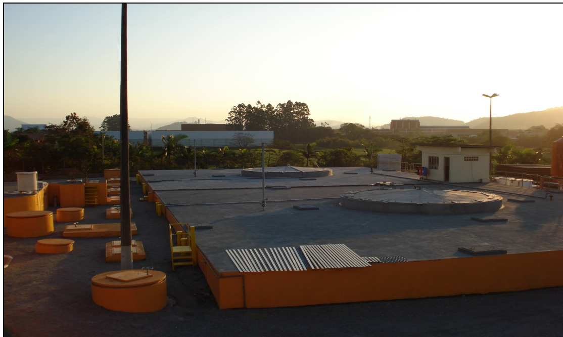
Figura 19: ETE Figueira – Tratamento Secundário: Reator Anaeróbio de Leito Fluidificante (2 Módulos)
