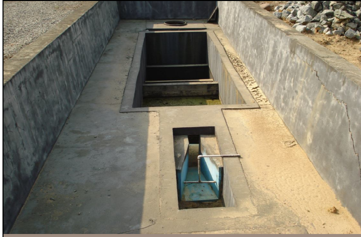
Figura 29: ETE Nereu – Tanque de Contato, Medição Final da Vazão e Desinfecção do Efluente.
