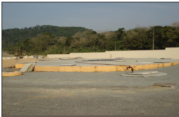
Figura 26: ETE Nereu – Reator Anaeróbio Tipo RALF.
