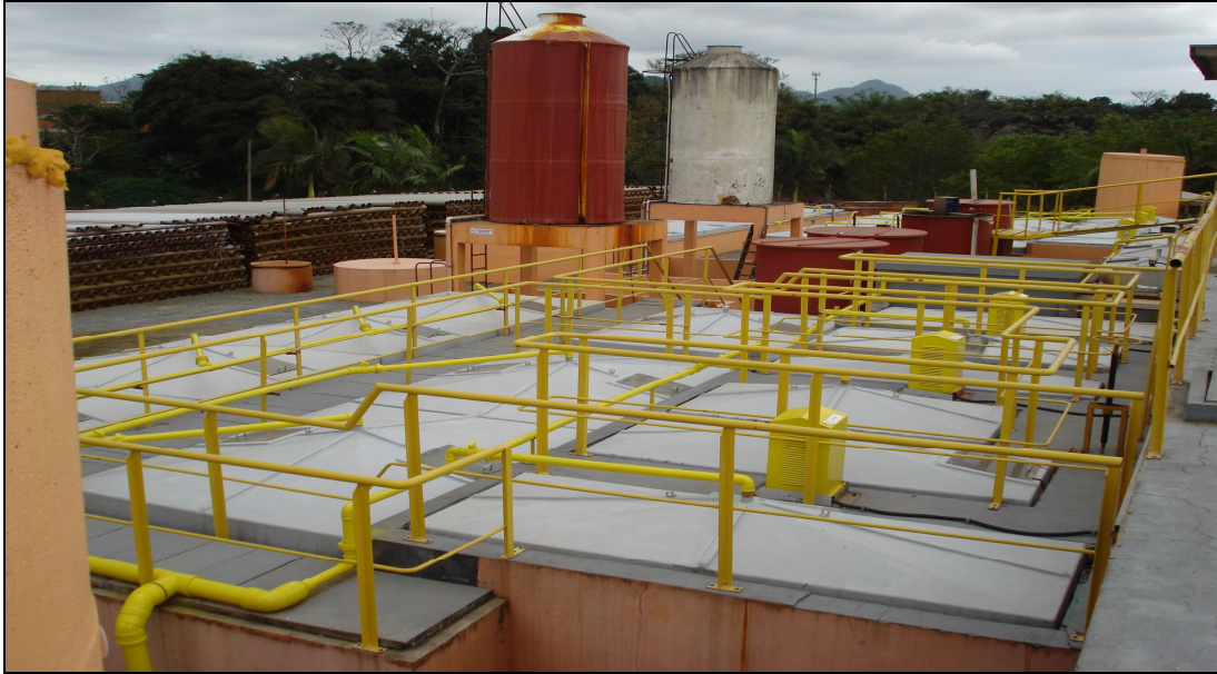
Figura 20: ETE Figueira – Tratamento Terciário: Físico-Químico, Floculadores e Decantador de Alta Taxa (2 Módulos).
