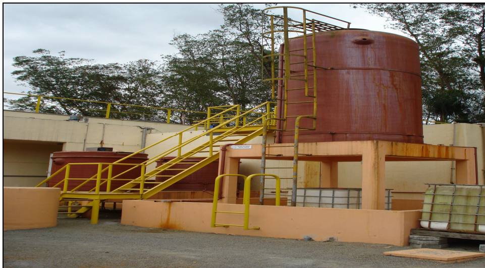
Figura 17: Tanques de Produtos Químicos (cloreto férrico, hipoclorito de sódio e anti-espumante).
