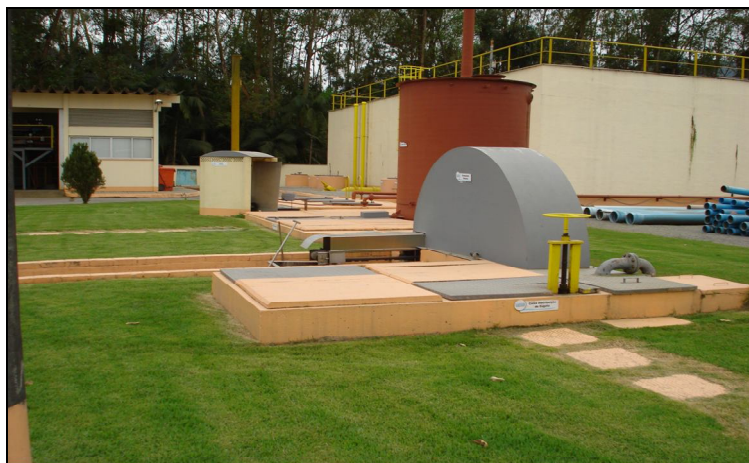
Figura 11: ETE Água Verde – Tratamento Preliminar – Gradeamento, Caixa de Areia, Calha Parshall e Estação de Recalque de Esgoto Bruto.
