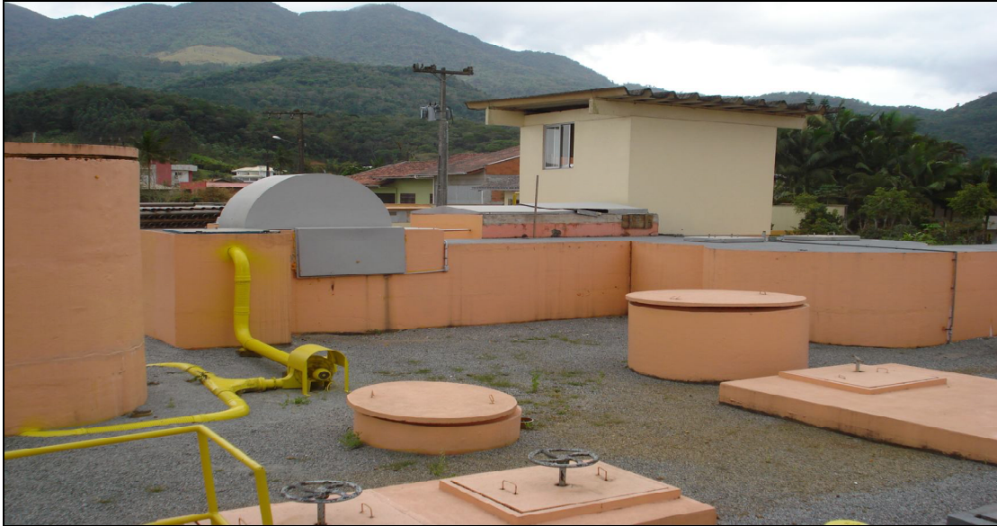
Figura 18: ETE Figueira – Unidades do Tratamento Preliminar: Gradeamento, Desarenação, Medição da Vazão de Esgoto Bruto e Caixa Distribuidora de Vazão.
