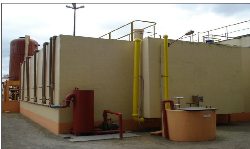
Figura 13: ETE Água Verde – Tratamento Terciário: Físico-Químico Floculadores e Decantadores.
