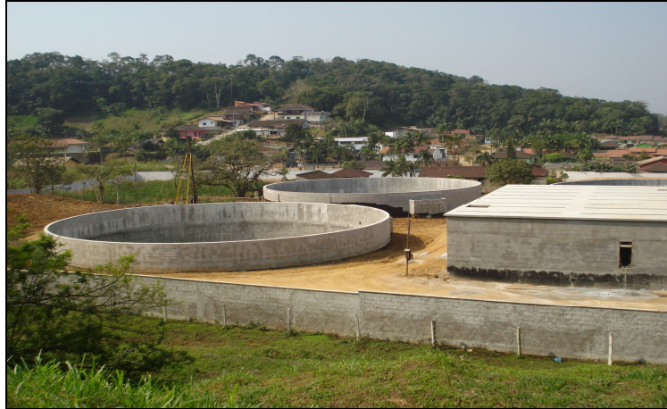
Figura 33: Reatores Aeróbios Tipo Seqüencial por Batelada.
