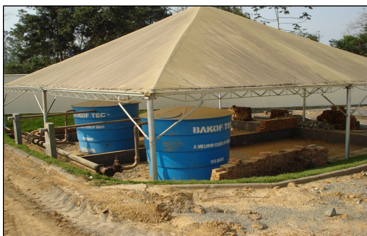
Figura 28: ETE Nereu – Adensadores de Lodo.
