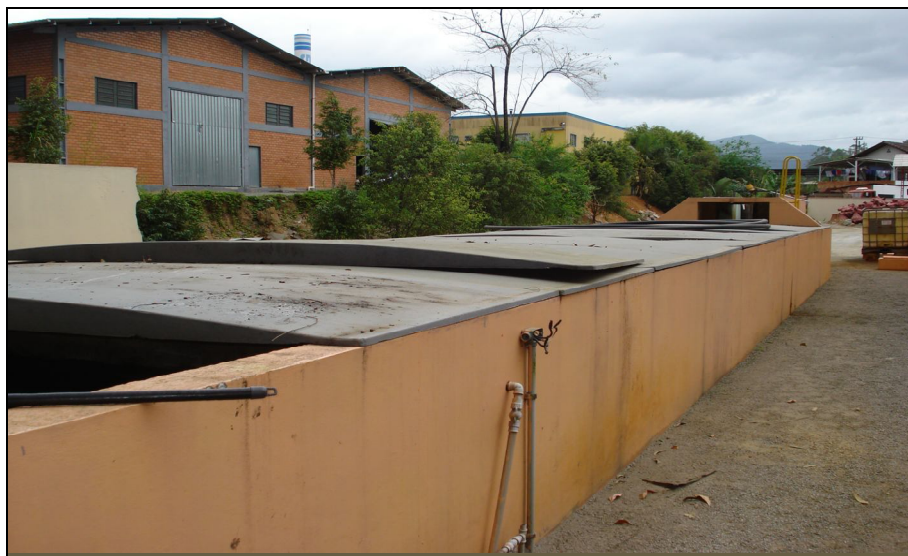
Figura 16: ETE Água Verde: Tanque de Contato para Desinfecção do Efluente.
